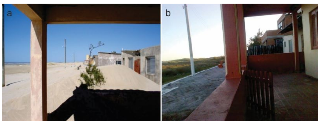
Figura 7: Fotografias mostrando os sedimentos invadindo as casas, em 2005, e a mesma área estabilizada, com desenvolvimento e estabilização das dunas frontais ao fundo, longe das moradias no período posterior a ação de manejo. Fonte: acervo pessoal
