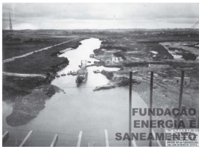
Legenda: Retificação do rio Pinheiros vista de cima da usina de bombeamento de Traição. Draga nº 1 draga em primeiro plano. 1940
