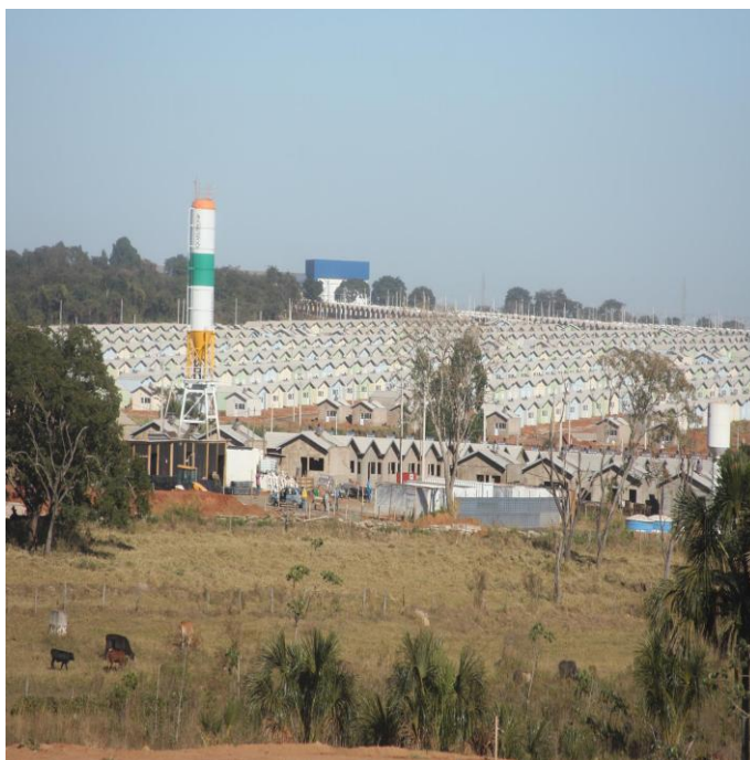
Figura 4: Vista do Residencial Pequís, Uberlândia-MG
