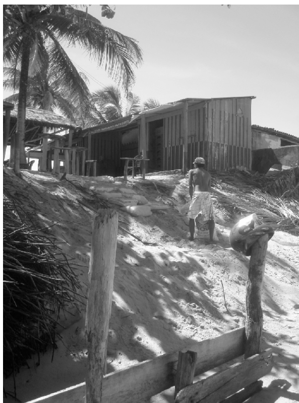
Figura 7. Evidências de erosão na praia de Saquáira.
