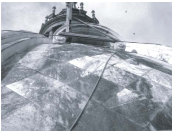
Figura 4 – Vista geral da Cúpula da Catedral Metropolitana de Porto Alegre destacando o enegrecimento parcial do revestimento de mármore.
