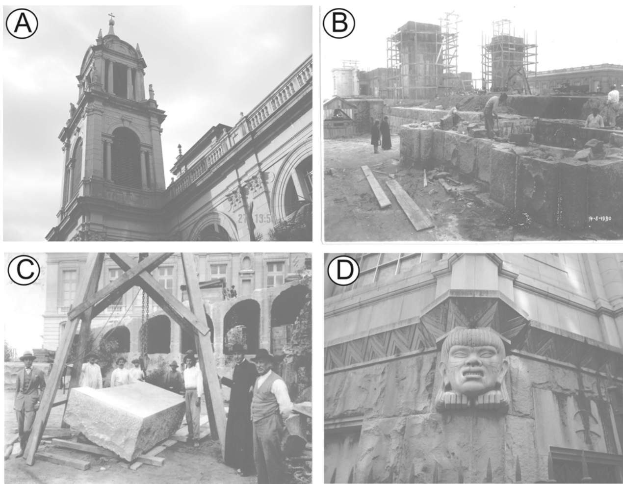
Figura 5. Fotos da catedral Metropolitana de Porto Alegre. A. Vista Lateral de uma das fachadas da catedral, construída com blocos do Granito Ponta Grossa; B. Imagem de 1930 da construção do embasamento do prédio da Catedral, destacando a colocação de blocos semi-acabados do Granito Ponta Grossa; C. Detalhe do alçamento de bloco do granito com cerca de 5 toneladas por guincho de madeira durante a construção da Catedral Metropolitana; D. Detalhe do embasamento do prédio da catedral destacando as estatuas de cabeça de índio, uma homenagem ao primeiros habitantes do estado.(Fotos B e C: cedidas pela Cúria Metropolitana).
