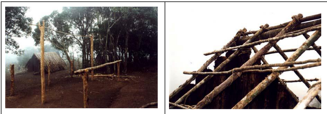
Figura 15: Cedro utilizado como estrutura de pilar da casa e vigas de cobertura.
