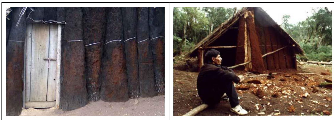
Figura 16: Xaxim como vedação lateral de paredes. Fotos: Paulo de Fernandes (2003).
