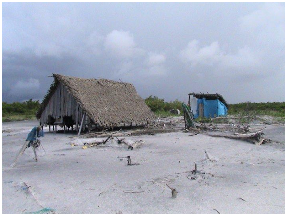
Figura 5: Depósito e latrina.
