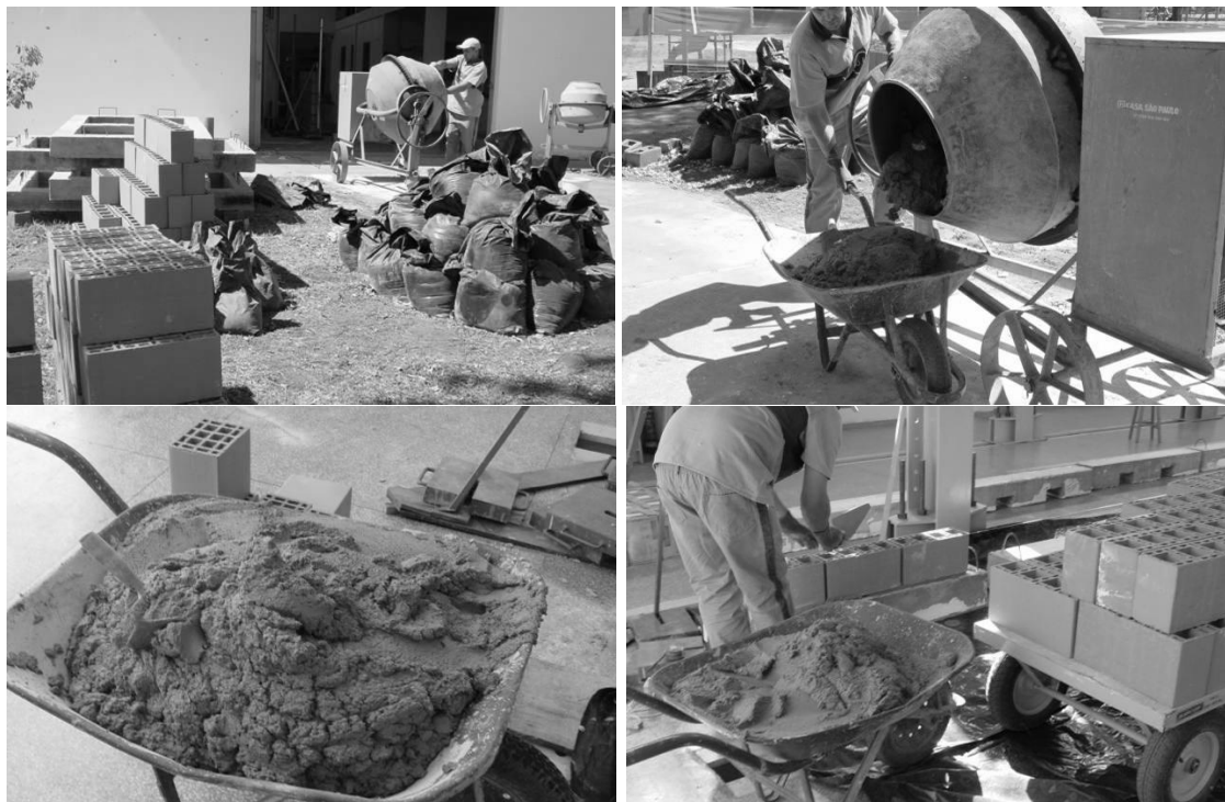
Figura 2 - Esquema de produção da argamassa de emboço e assentamento
