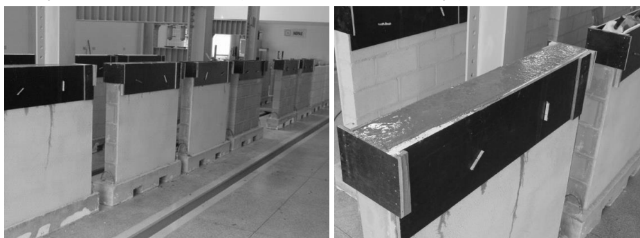
Figura 7 - Execução das vigas superiores (paredes com e sem emboço)
