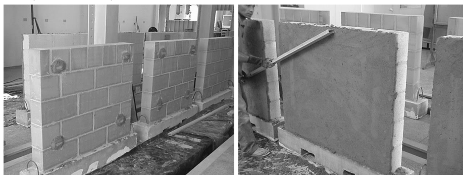
Figura 6 - Execução dos emboços das paredes cerâmicas
