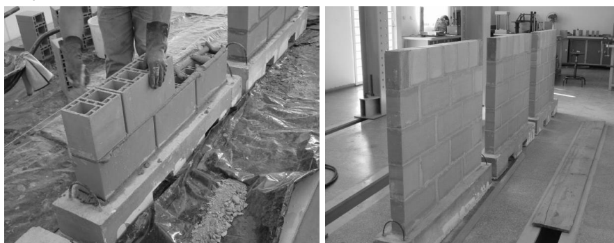
Figura 5 - Execução das paredes cerâmicas
