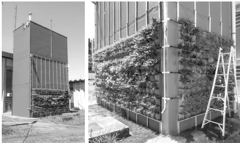
Figura 4 - Torre com a parede viva experimental: fachadas norte (maior) e oeste (menor)
