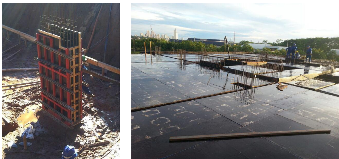
Figura 18 - Fôrmas de pilar e de lajes executadas
