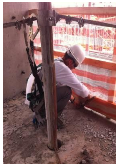
(b) Fixação da tela de proteção do SPP-MA-2
