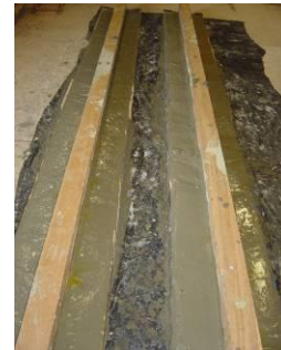
(c) Concretagem das vigas mistas
