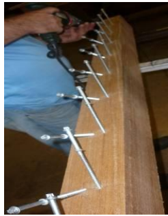
(a) Conectores de cisalhamento em X
