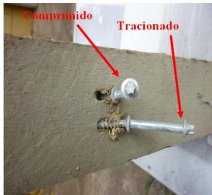
Figura 15 - Modos de falha e deformação dos conectores: tendência de arrancamento dos conectores tracionados e formação de rótulas plásticas nos conectores comprimidos
