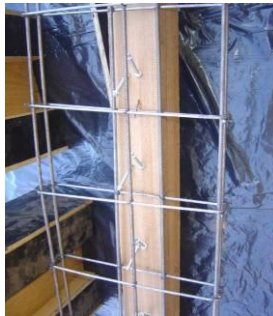
(b) Armadura para o concreto
