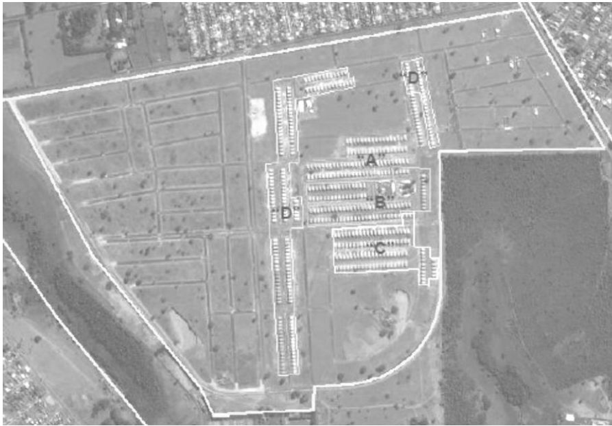
Figura 1 - Foto aérea do conjunto habitacional
