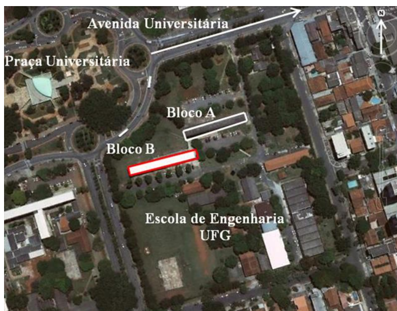
Figura 1 - Localização dos edifícios das Escolas de Engenharia da Universidade Federal de Goiás, no Setor Leste Universitário, em Goiânia, GO
