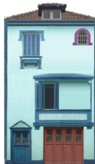
Figura 3 - Edifício 1: edifício histórico com desordem
