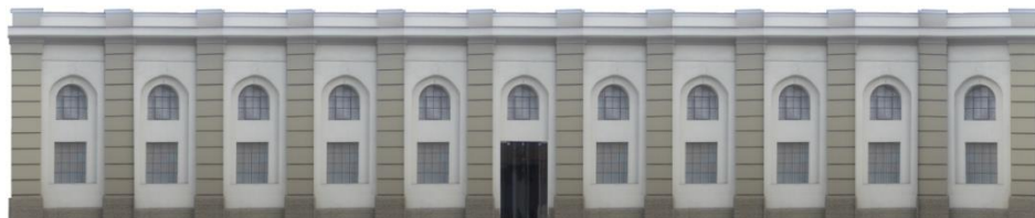
Figura 4 - Edifício 2: edifício histórico com ordem e pouco estímulo
