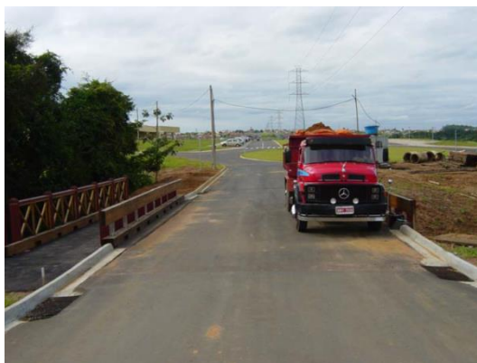
Figura 1 – Vista da ponte multicelular de madeira protendida
