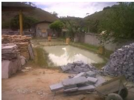
Figura 8 - Unidade de tratamento de efluentes (tanques de decantação) em uma empresa da região
