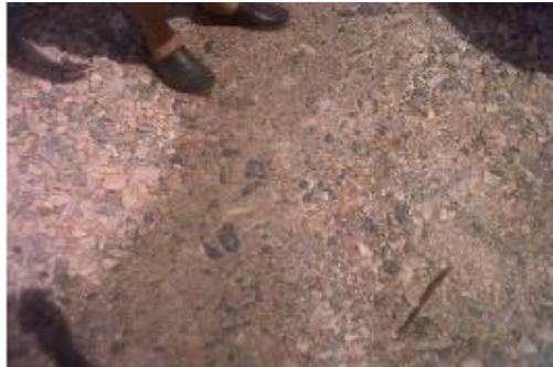
Figura 17 - Estrada vicinal com resíduo da indústria de rochas ornamentais, após utilização dos agregados de menor granulometria
