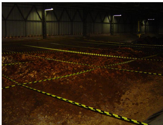
(b) Demarcação dos quadrantes no aterro
