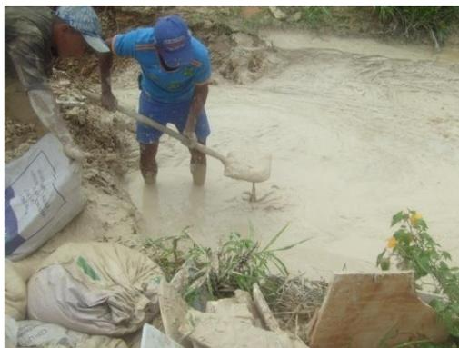
Figura 1 - Detalhamento da retirada do RSPC do tanque de decantação
