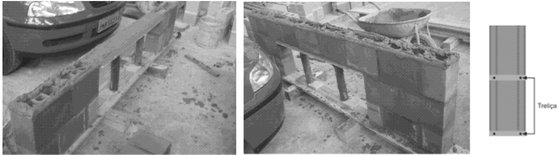
Figura 11 - Execução das vergas do modelo VL
