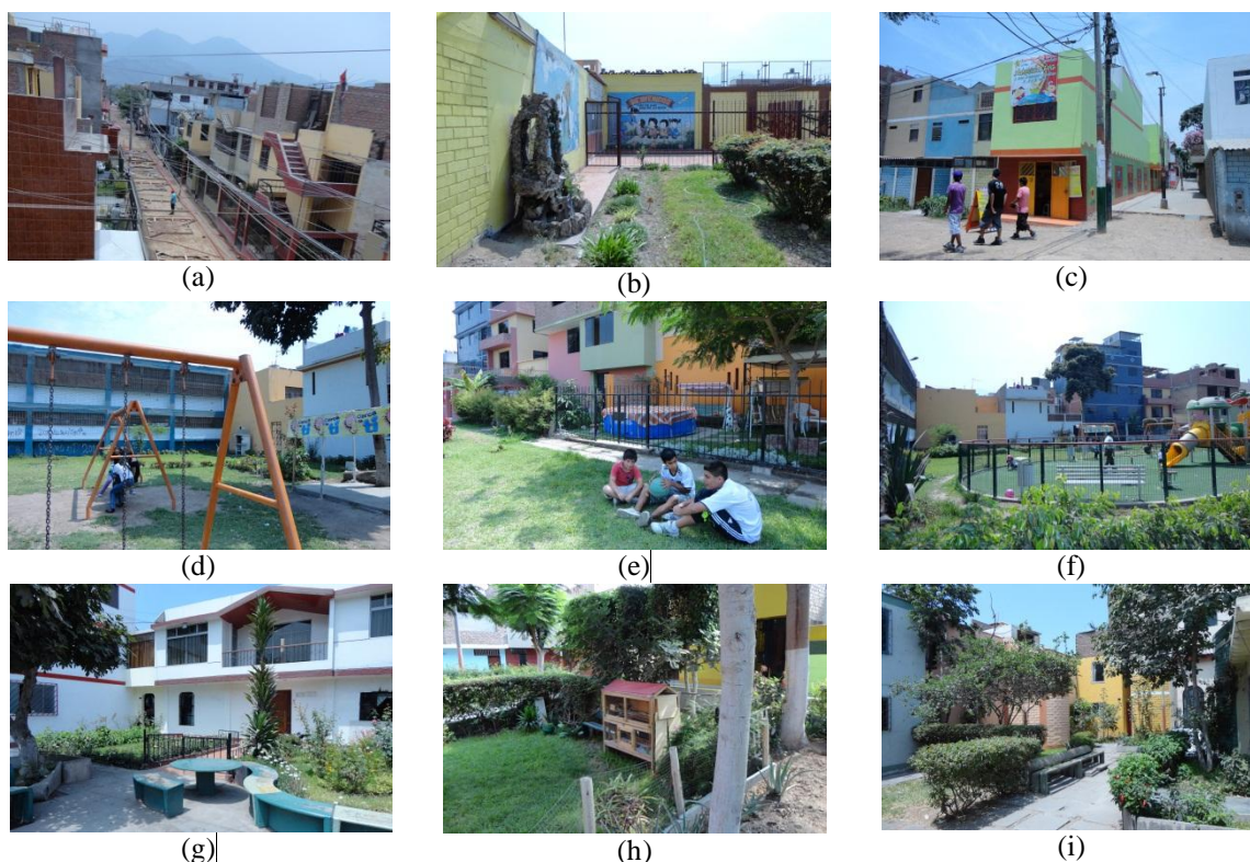
Figura 4 - Implantação do conjunto: (a) Alameda central (calçamento em manutenção), (b) e (c) Creches municipal e privada, (d), (e) e (f) Colégio Jorge Basadre e respectivos espaços abertos e (g), (h) e (i) Pequenas praças delimitadas por moradias
