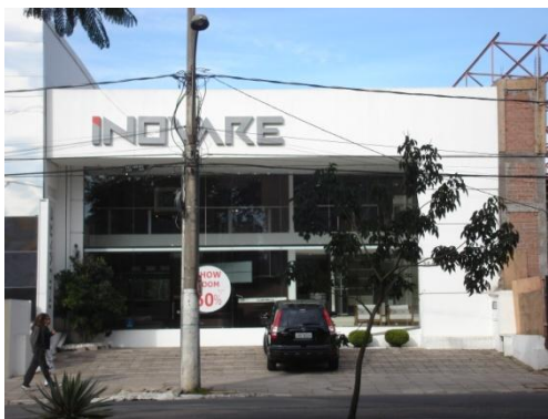
Figura 15 - Loja Inovare - edificação contemporânea
