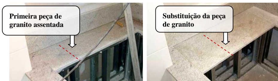
Figura 12 - Substituição da peça de granito da banheira
