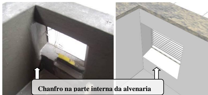
Figura 6 - Chanfro interno e configuração final dos revestimentos da banheira
