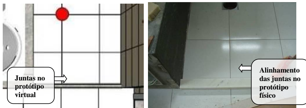
Figura 8 - Diferença entre alinhamento das juntas no protótipo virtual e no físico
