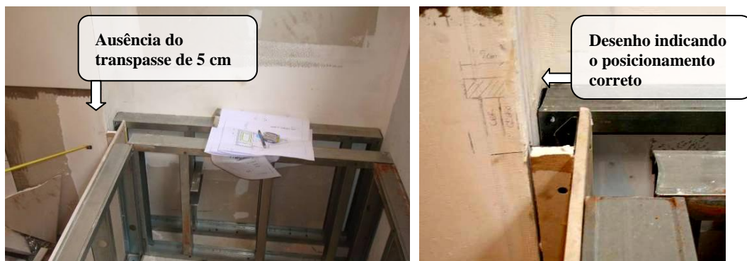
Figura 11 - Primeira execução da estrutura de apoio para a banheira e desenho apresentando o posicionamento correto
