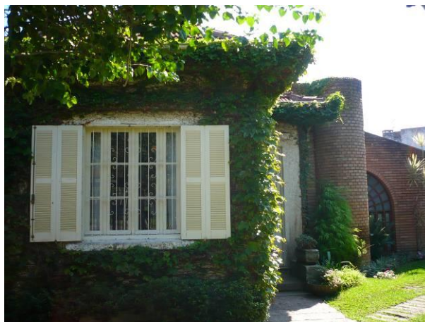
Figura 6 - Edificação estudada em Porto Alegre, na qual a parte antiga foi revestida por pele-verde da espécie Parthenocissus tricuspidata como forma de se harmonizar à ampliação da residência, em tijolo à vista (2008)
