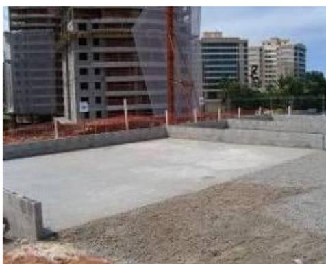
Figura 4 - Baias de agregado reciclado
