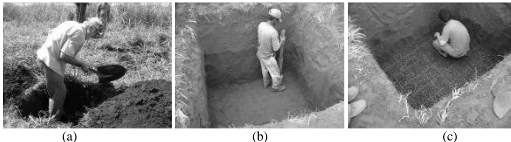
Figura 6 - a) Escavação das unidades; b) Apiloamento de fundo para concretagem; c) Preparação da armadura para concretagem da laje de fundo
