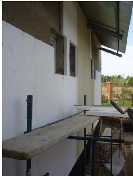
Figura 5 - Terminación sobre aislación térmica en el muro Su
