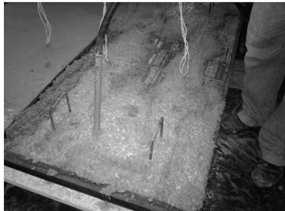
(b) lançamento e adensamento do concreto
