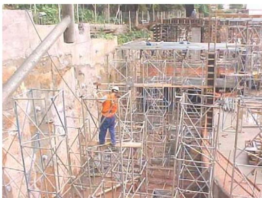
Figura 5 - Atividade de montagem e desmontagem de torres de escoramento que gerou quase-acidentes de retorno positivo e negativo.
