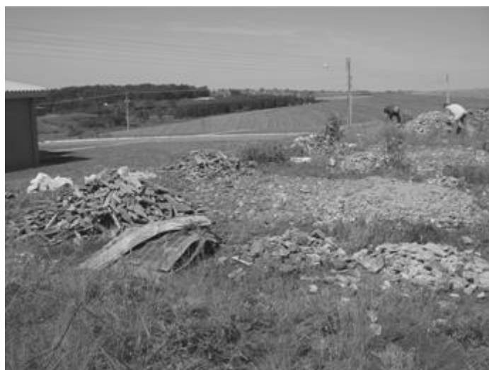
Figura 3 - Detalhe das cargas de RCD separados manualmente por tipo de material
