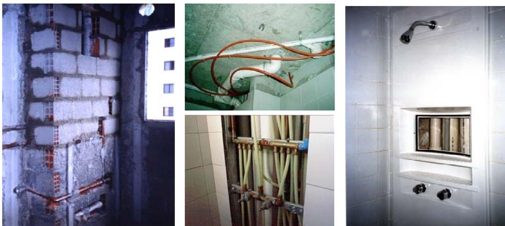
Figura 5 - Solução convencional de distribuição de água fria *versus* solução em tubulação flexível (PEX) e shafts visitável. Fotos: Autor e Waltermirino Jr.
