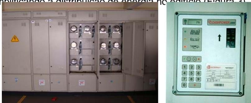
Figura 3 - Bateria de medidores de energia no térreo (solução convencional) e medidor eletrônico dentro do apartamento. Fotos: Autor e Waltermirino Jr. (2004).
