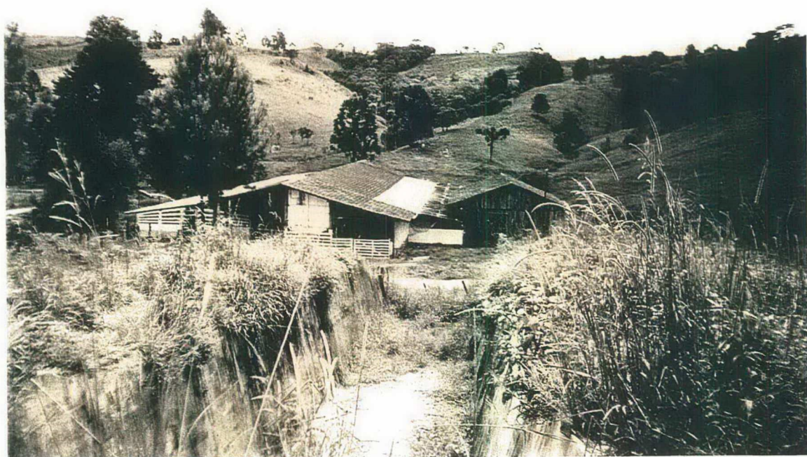
FOTO 1: SILO TRINCHEIRA e AO FUNDO O CONFINAMENTO
