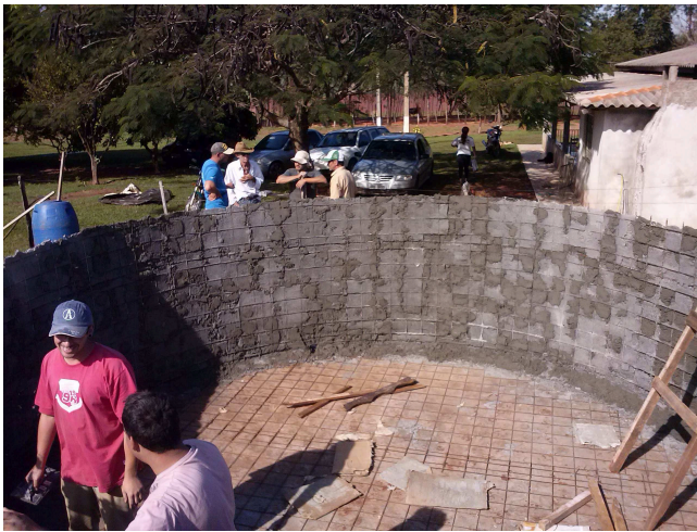
Construção da cisterna
