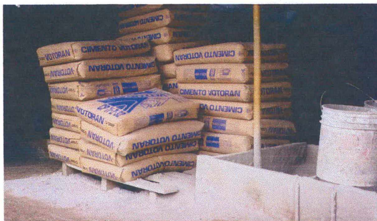
Figura 8: Sacos de cimento armazenados. Foto: Edifício Antares, em 15/01/2001.
