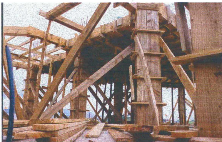
Figura 4: Madeiras para caixarias na fase de estrutura. Foto: Edifício Antares, em 15/01/2001.
