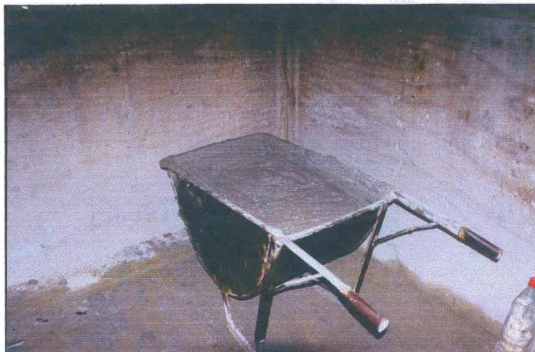
Figura 7: Carrinho para transporte de argamassa. Foto: Edifício Antares, em 15/01/2001.
