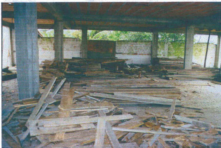
Figura 5: Sobra de madeiras utilizadas em caixarias Foto: Edifício Antares, em 15/01/2001.
