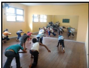
Figura 162: Paredes internas – Sala de capoeira Fonte: Autora
