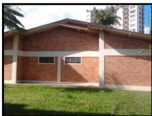
Figura 36: Fachada norte – Edificação principal
