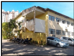
Figura 191: Edificação Serviço de Assistência Infantojuvenil Fonte: Autora
