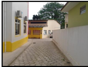
Figura 192: Edificação posto de saúde Itacorubi Fonte: Autora
