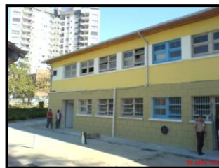
Figura 41: Fachada leste – Edificação secundária Fonte: Autora
