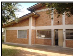
Figura 130: Inexistência de marcações de caminhos Fonte: Autora
