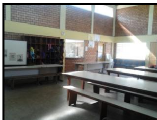
Figura 157: Piso em concreto – Refeitório Fonte: Autora
