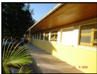
Figura 40: Fachada oeste – Edificação secundária Fonte: Autora
