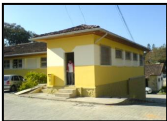
Figura 129: Inexistência de marcações de caminhos Fonte: Autora
