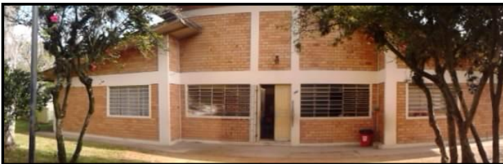
Figura 35: Fachada sul – Edificação principal
