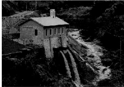
Figura 1 – Usina hidrelétrica marmelos zero. Extraído de (ELETROBRAS, 2013)
