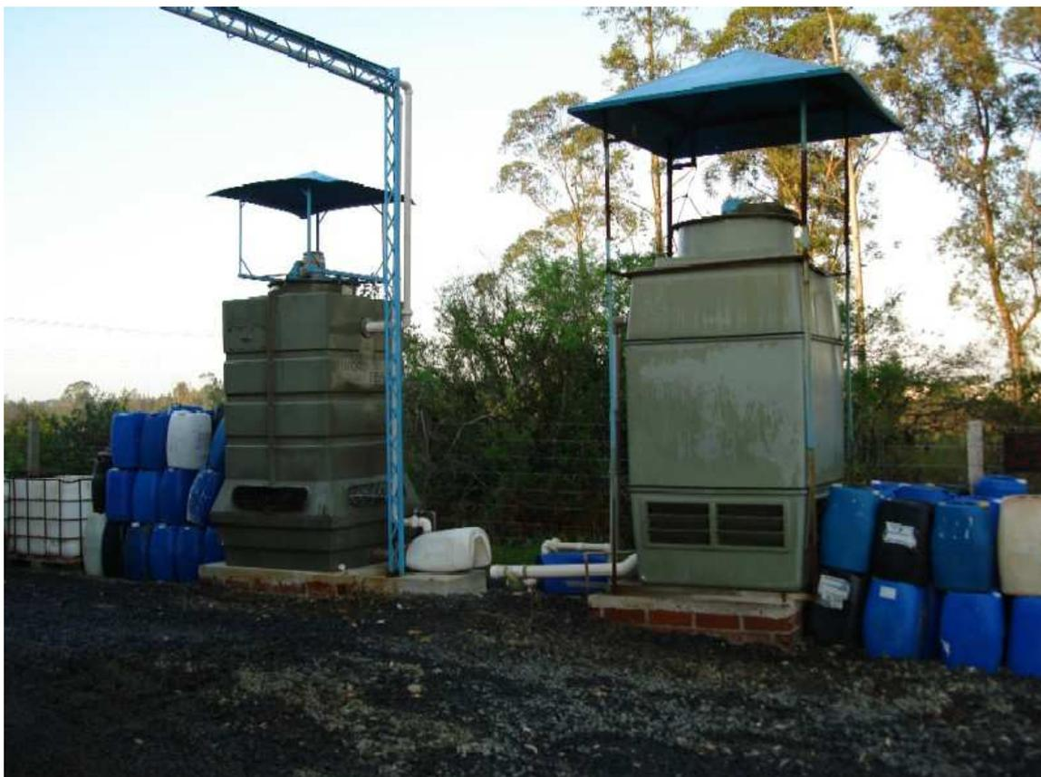
**Figura 5.** Foto das torres de resfriamento no exterior da fábrica.
