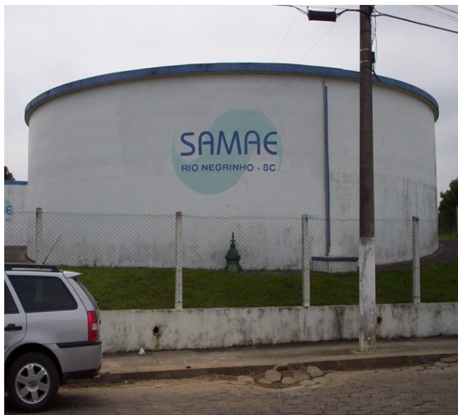
Figura 8: Reservatório de água tratada.
