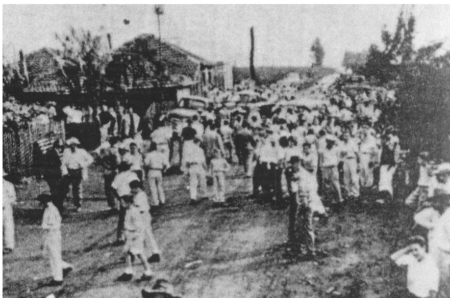
FIGURA 13 – Venda de Secos e Molhados, já demolida, onde os moradores da redondeza reuniam nos finais de semana e feriados. Prefeitura Municipal de Maringá – Acervo da Divisão de Patrimônio Histórico
