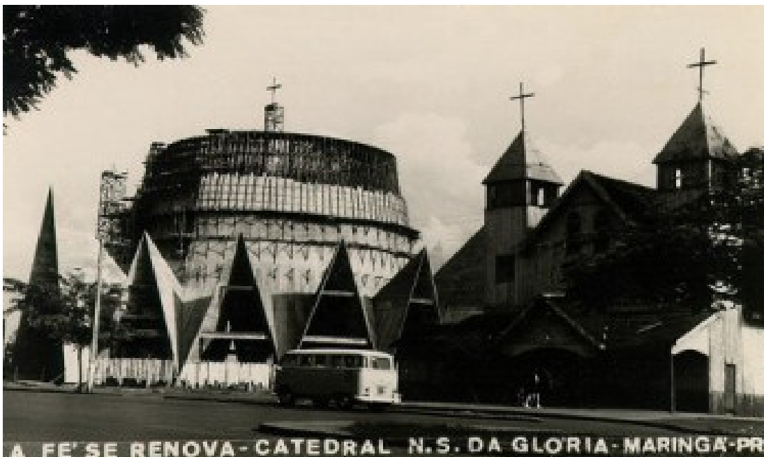
Figura 15b Vista da Nova catedral em construção. Em destaque a antiga igreja que só foi demolida após o término da construção.
