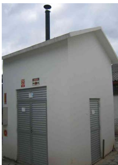
Figura 4.16 Fotografia da casa da caldeira.
