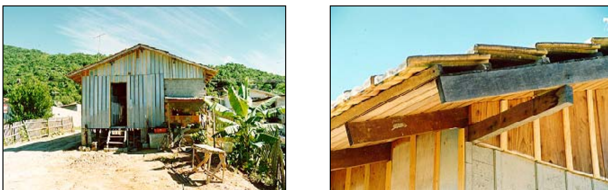
Figura 2 - Sistema construtivo em tábuas verticais com mata-juntas.
