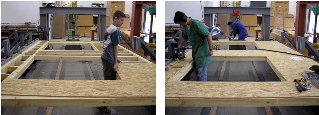
Figura 56 - Seqüência de montagem de um protótipo de parede com duas aberturas de janela.
