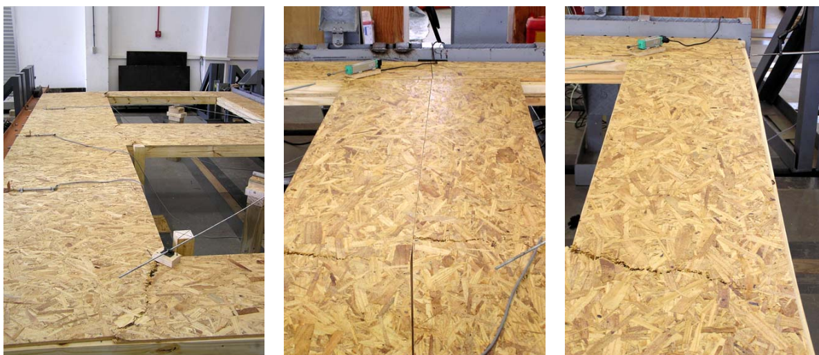
Figura 71 – Ruptura pelo rasgamento das chapas nos cantos de janela nos protótipos P488-2J.
