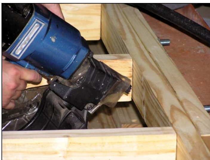
Figura 74 - Fixação por pregos da segunda travessa inferior à guia previamente presa à base por parafusos.
