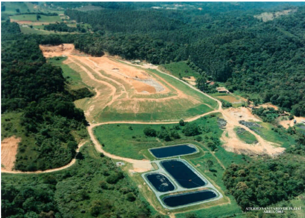
Figura 6.2 – Aterro de resíduos de Itajaí FONTE: Engepasa Ambiental
