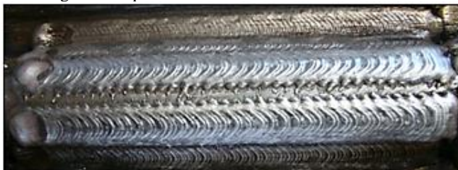
Figura 61 – Defeitos de soldagem devido à inadequada relação entre velocidade de soldagem e frequência de tecimento.
