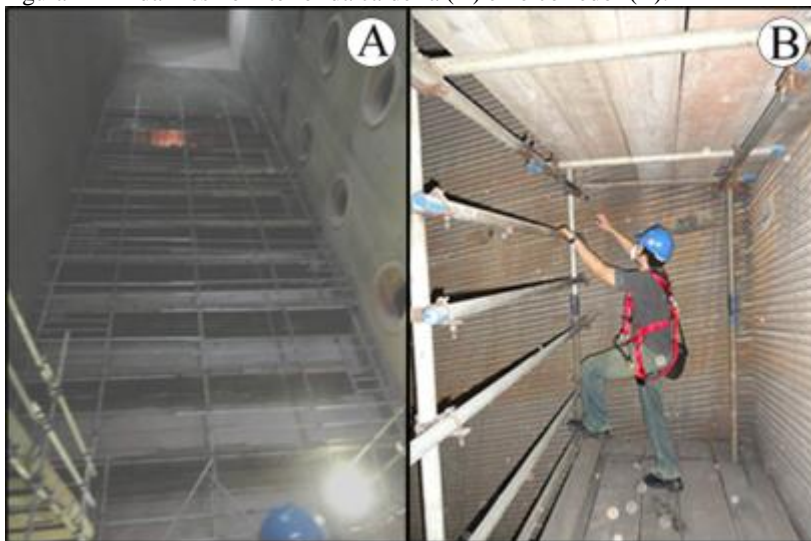
Figura 4 - Andaimes no interior da caldeira (A) e no corredor (B).
