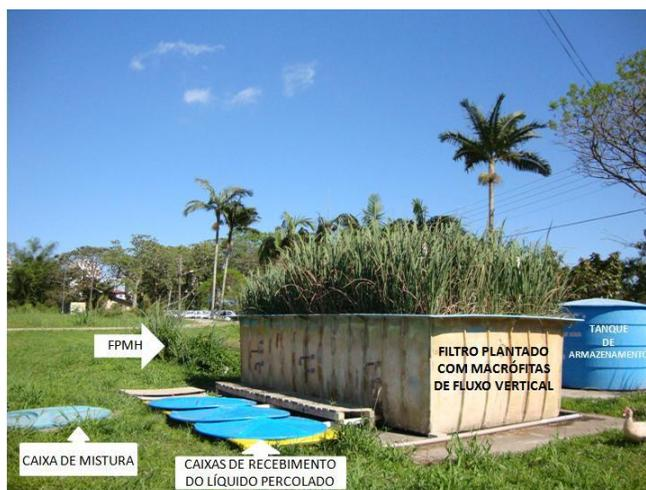
Figura 3 – *Layout* dos principais componentes do sistema de tratamento de lodo de tanque séptico.
