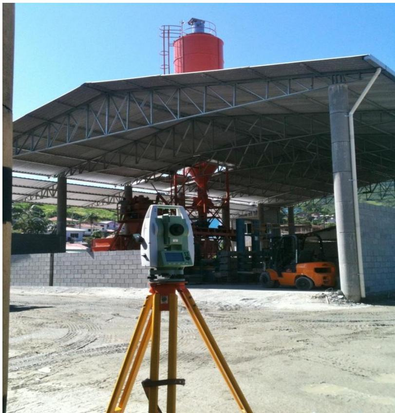
**Figura 74 – Instalação da Estação-base para início das medições pelo Método de Estação Total.**
