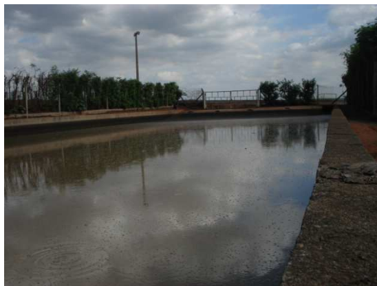
Figura 7. Tanque/recalque para água e/ou vinhaça da Usina Esther, nas proximidades da SP-332.
