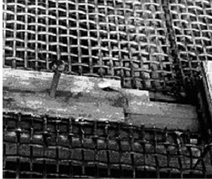
Figura 3 – Pavilhão da Checoslováquia na Expo 92 de Sevilha. Estado em que se apresentavam os elementos de aço galvanizado.
