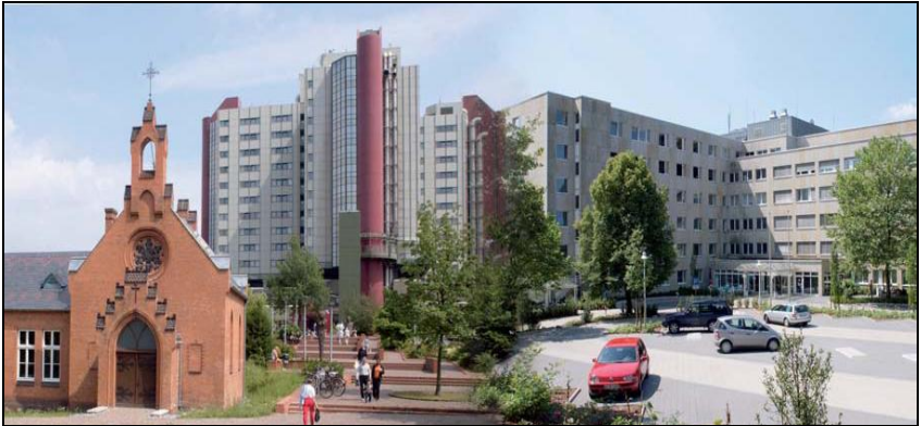
Figura 6: Hospital Städtische Kliniken Bielefeld e Hospital Standort Rosenhöhe
