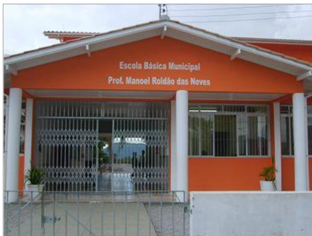
Figura 1 – Fachada da Escola Roldão, onde foi realizada a pesquisa de campo 25 .
